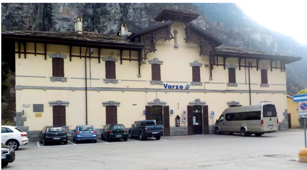
La gare fut sans doute construite aux grandes heures du creusage du tunnel du Simplon, inauguré en 1906.
