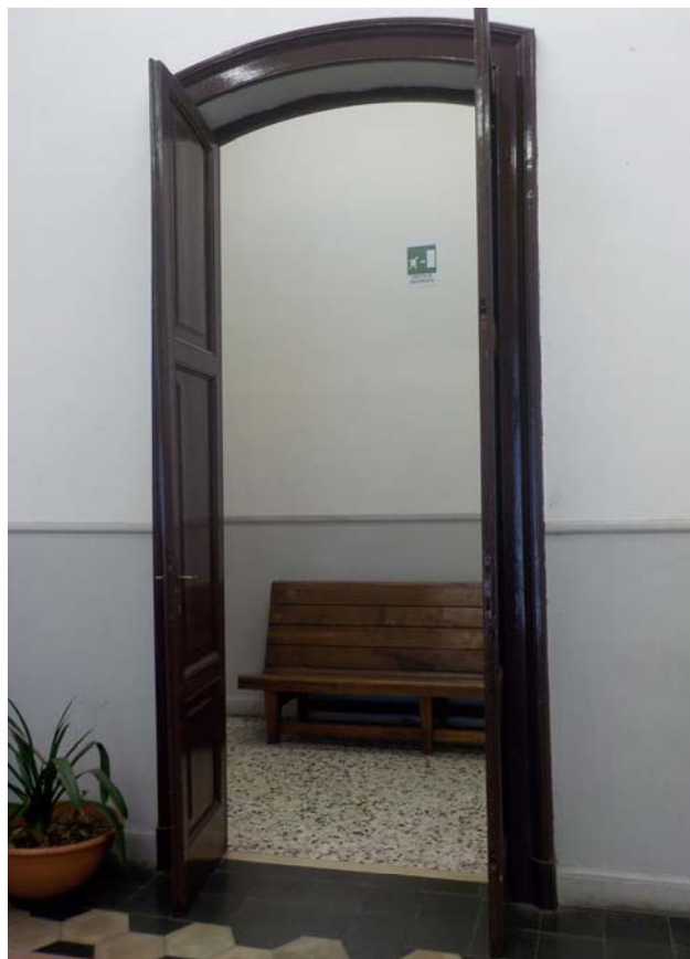
Portes de locaux ferroviaires, toujours adaptées à des géants. L'espèce peut donc encore grandir !
